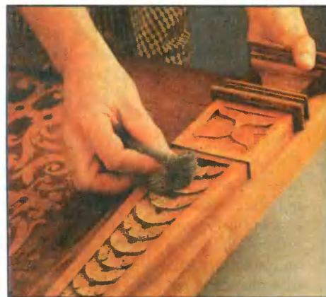
С помощью грубой стальной шерсти можно легко удалить остатки смывки из углублений резных узоров.
